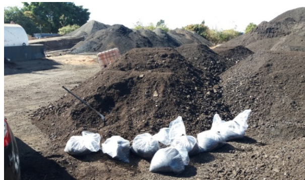
Figura 7. Coleta material fresado.
