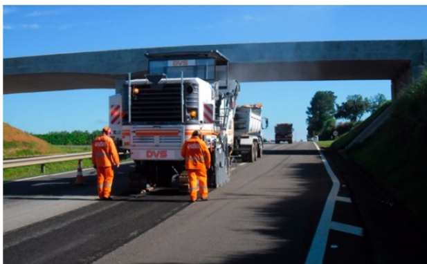
Figura 1. Processo de fresagem (BONFIM, 2007).
