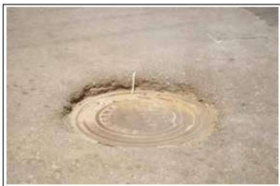
Figura 2: Desnível de 10 cm entre a pista e o tampão de ferro, resultado de dois recapeamentos sem a retirada do revestimento anterior (BONFIM, 2007).
